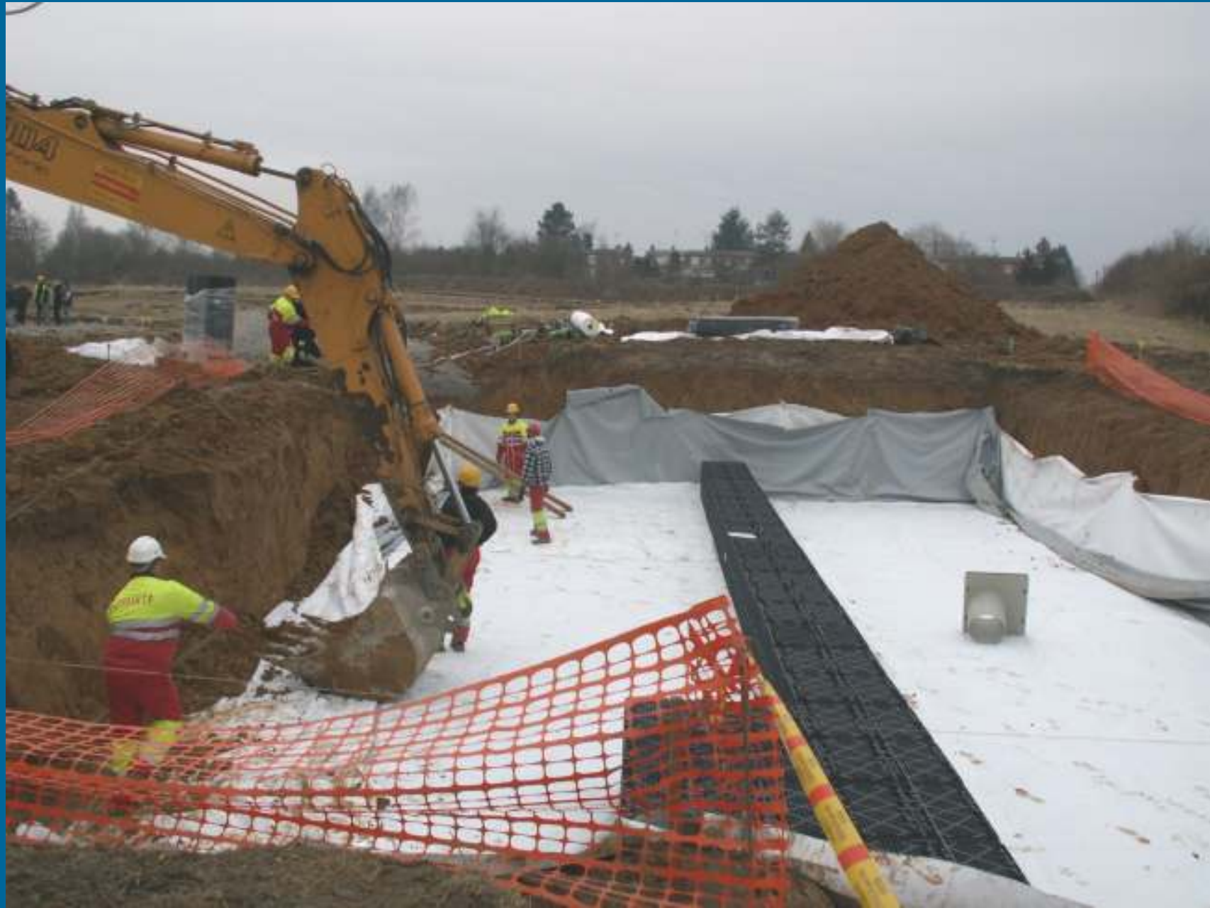
Lotissement sur Level
