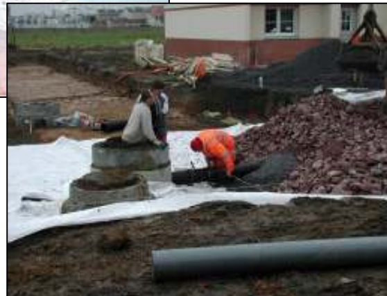
Mise en place du géotextile, de la grave et du drain
