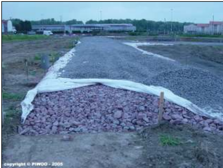
Mise en place de la grave bitume
