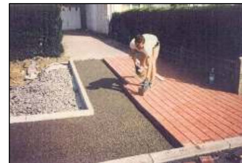
Mise en place de la couche de surface
