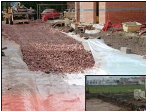
Mise en place du géotextile, de la grave et du drain
