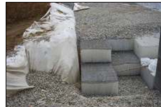
Géotextile et structure alvéolaire
